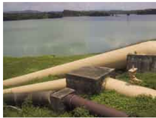
烏山頭ダムの取水管
