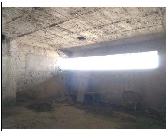
圖11 半屏山北砲臺中層砲堡內部
